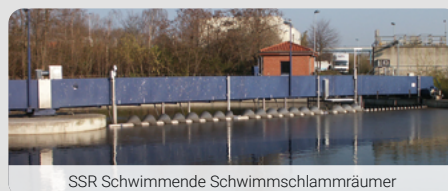
SSR Schwimmende Schwimmschlammräumer
