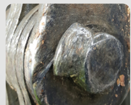
Schweisnaht bricht im Praxiseinsatz.
